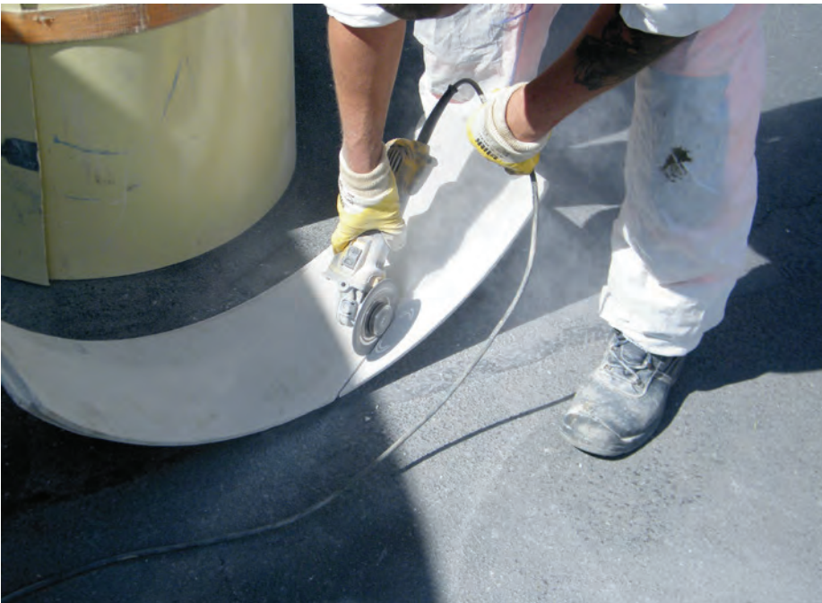
Ein Tübbing wird für den Einbau in den Schachtkonus vorbereitet.
