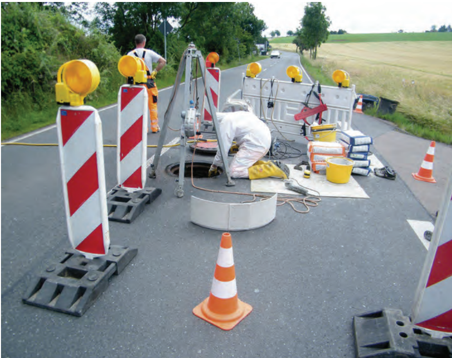
Ein neues Schacht-in-Schacht-Sanierungsverfahren mit Polymertübbingem bestand in Meißen den Härtetest.
