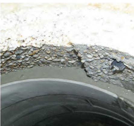
Vergussmörtel im Ringraum
