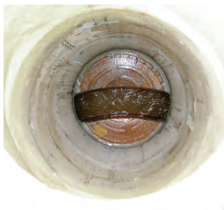
Stabil, bruchfest und platzsparend: Schachtsanierung mit Polymertübbingen | Fotos: IKT
